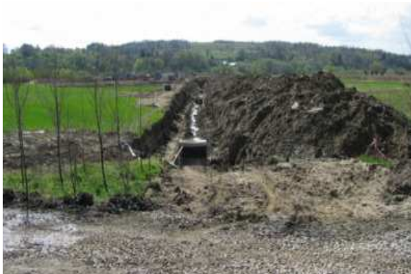
Kanalizacja wsi Przysieki – prace ziemne
